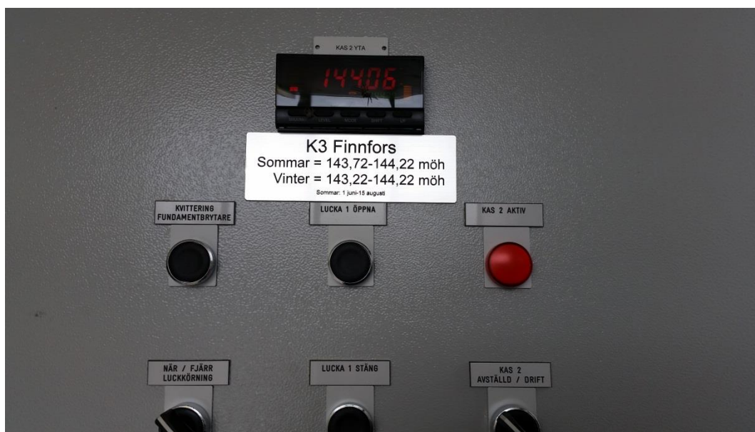
Figur 4 vatten nivå i Finnfors Kraftstation
