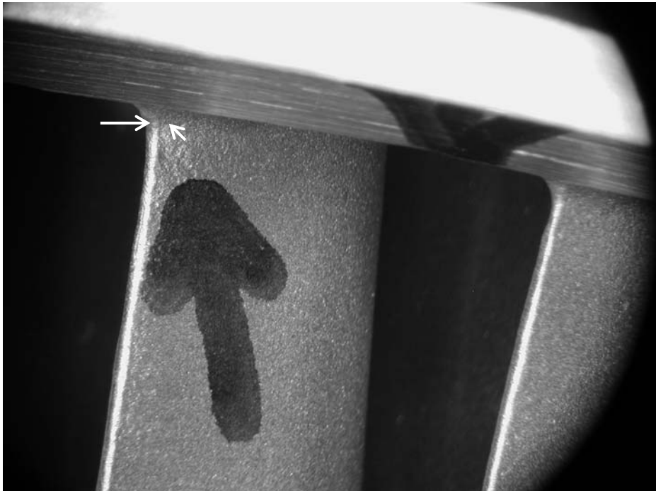
Foto av sprickorna på ledsidan.
