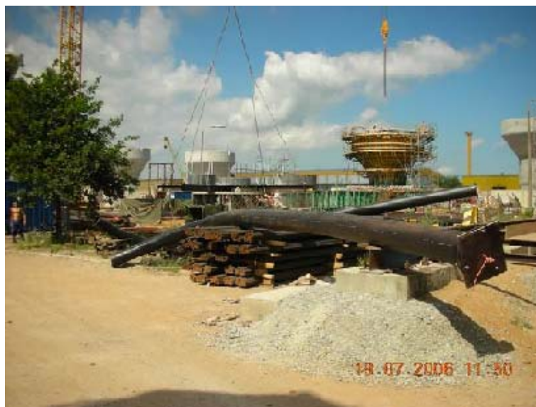
Figur 5 Kabelrör så kallad J-tube för vindkraftparken Lillgrund Foto: Niklas Grahn
