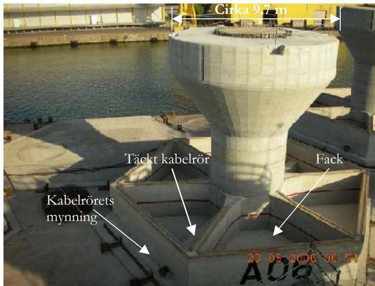
Figur 4 Gravitationsfundament av betong för vindkraftparken Lillgrund Foto: Niklas Grahn
