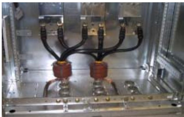
Bild 2-7 visar tydligt hur skärm och jord dras förbi på utsidan filtret. (Bild ABB)
